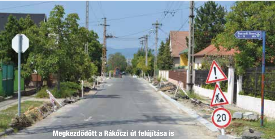
Megkezdődött a Rákóczi út felújítása is
